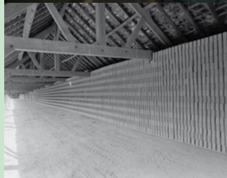
Glos, briqueterie Lagrive, halle de séchage. © Photo Pascal Corbierre, 1987.
