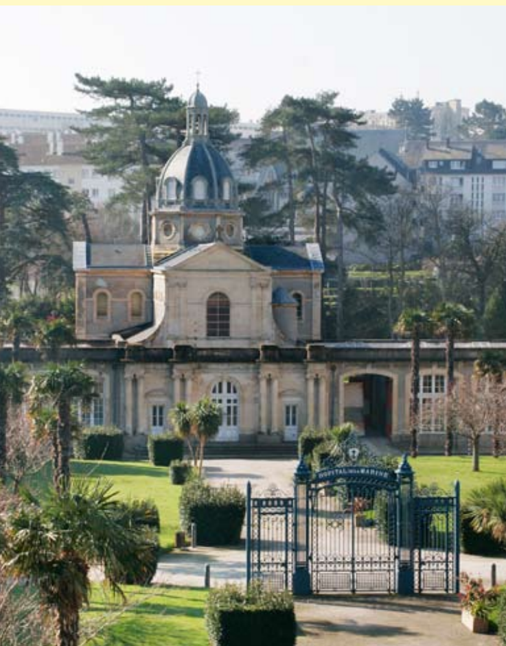
La chapelle de l'hôpital maritime par l'ingénieur Pasquier-Vauvillier, 1872. © Photo Manuel de Rugy, 2007.
