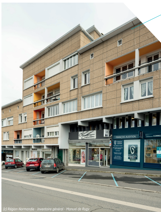
Ensemble du Haut-Chemin, de l'architecte Claude Herpe, ayant fait l'objet d'une restauration en 2018-2019.
